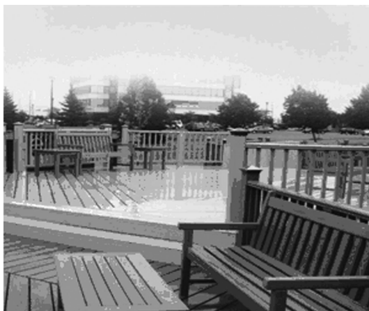
图 12 50%秆芯粉和 50%PVC/PE 制备的室外平台
